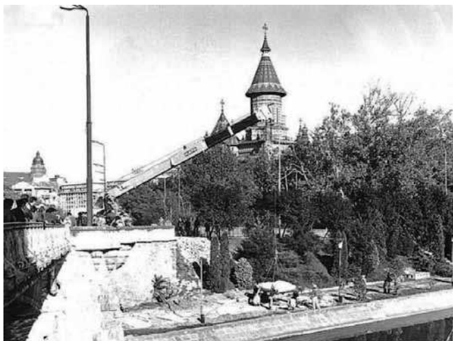
Detaliu din timpul instalării „Pernei”
